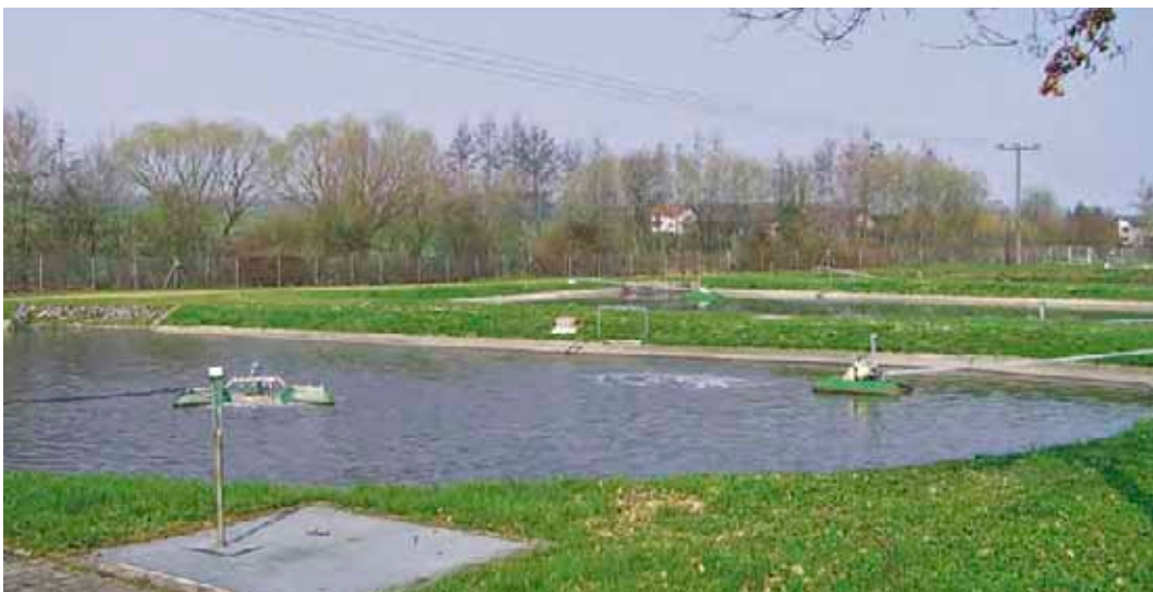
Belüftete Abwasserteichanlage in Bayerbach bei Ergoldsbach (2.600 EW Ausbaugröße)
