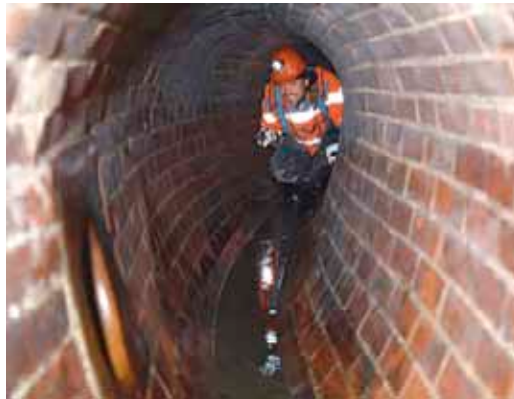
Bild links: Optische Inspektion eines begehbaren Kanals
