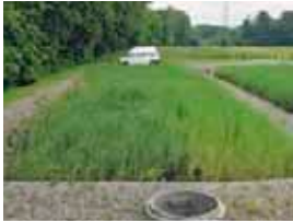
Pflanzenkläranlage als horizontal durchströmter bepflanzter Bodenfilter in Mundraching (350 EW Ausbaugröße)
