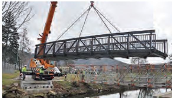
Erfbrücke in Bürgstadt
