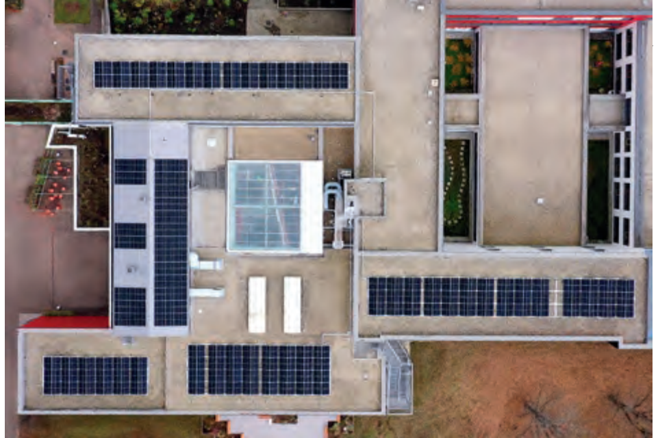
Wie hier auf dem Hermann-Staudinger-Gymnasium Erlenbach werden die Solarenergiepotenziale auf den Kreisliegenschaften schrittweise erschlossen. © Solkraft
