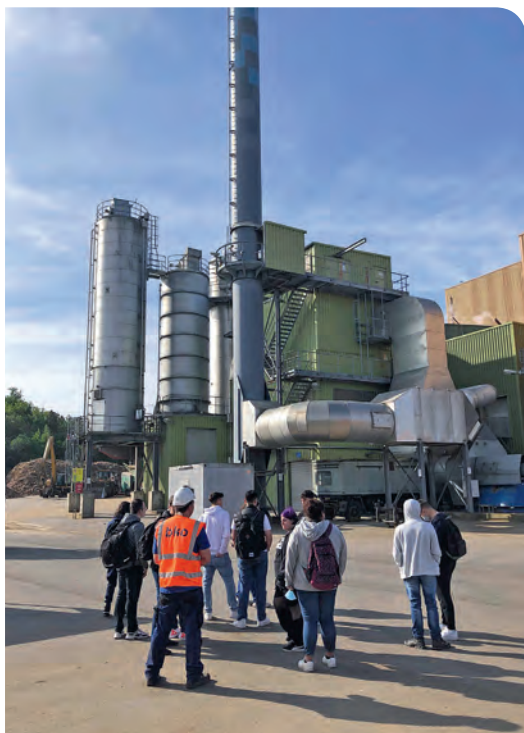
Im Biomasseheizkraftwerk Buchen wird rund um die Uhr Altholz verwertet.
