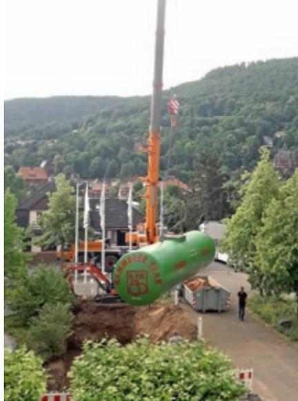
*Das Pelletslager musste aus Platzgründen außerhalb des Gebäudes installiert werden, es bietet Platz für 26 Tonnen Holzpellets.*
