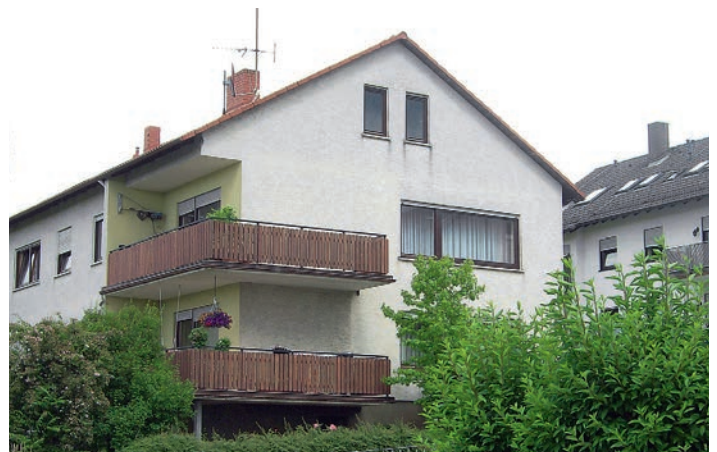
Das 2-Familienhaus aus Mönchberg vor der Sanierung.
