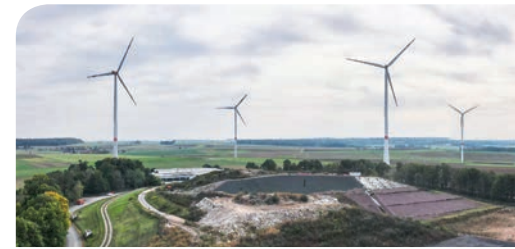
Ablagerungsbereich der Kreismülldeponie Guggenberg. Bild: Patrick Höchst, hoechst creativ GmbH, Solms-Oberbiehl
