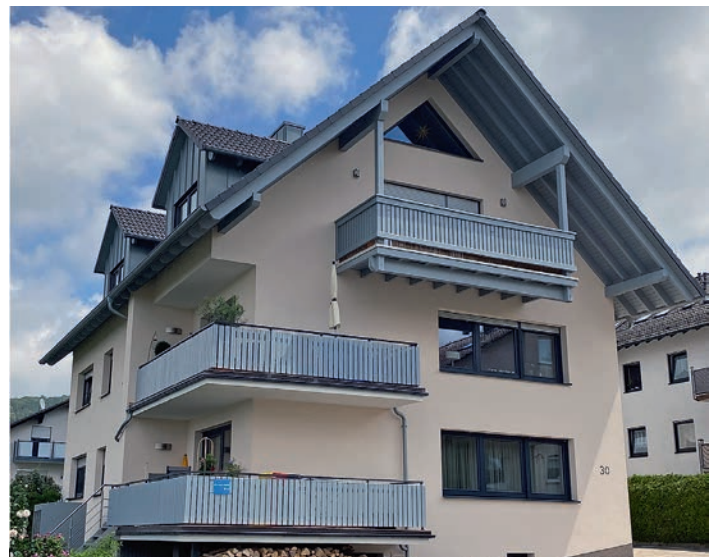
Das Gebäude nach der umfänglichen energetischen Sanierung inklusive Dachausbau.
