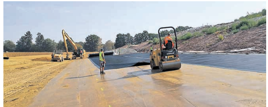
Verlegung der Kunststoffdichtungsbahn auf der mineralischen Dichtung
