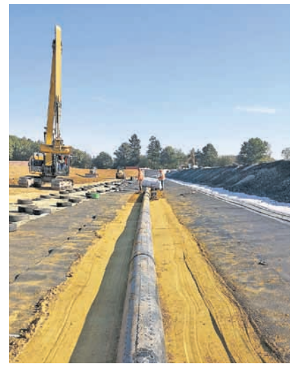
Verlegung der Deponiesickerwasserleitung
