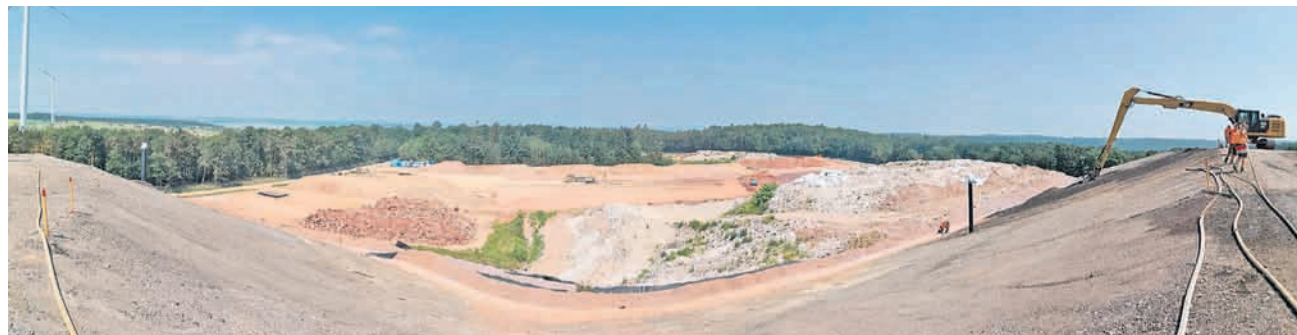
Im Vordergrund: Errichtung des Probefeldes für die Zwischenabdichtung; im Hintergrund: Herrichtung des Planums für den neuen Bauabschnitt.
