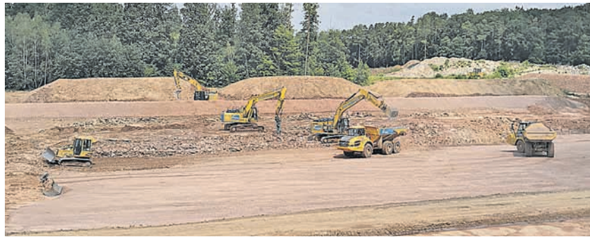
Herrichtung des Planums für den neuen Abschnitt: Zerkleinern von Buntsandsteinblöcken sowie Lösen und Verladen von durch die Basisabdichtung verdrängtem Erdreich.
