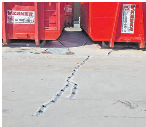
Abgedichtete Risse auf dem Wertstoffhof der Müllumladestation Erlenbach
