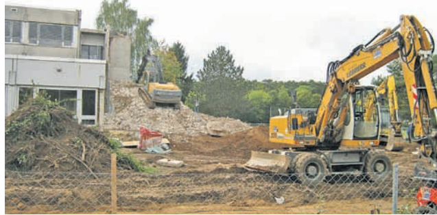
Erste Baustellentätigkeiten waren Abbruchmaßnahmen von je zwei Musiksälen und Unterrichtsräumen. Hier sind noch die Reste des abzubrechenden Treppenhauses zu sehen. Die Erdarbeiten beginnen bereits parallel zum Abbruch.
