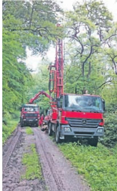
Große Bohrgeräte sind erforderlich, um die Grundwasser-Messstellen zu errichten.
