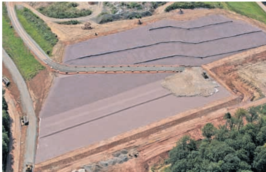
Im Vordergrund die neue DK-II-Deponie, Verfüllstand September 2009; rechts die mit arsenhaltigem Schotter belegte Nordböschung.
