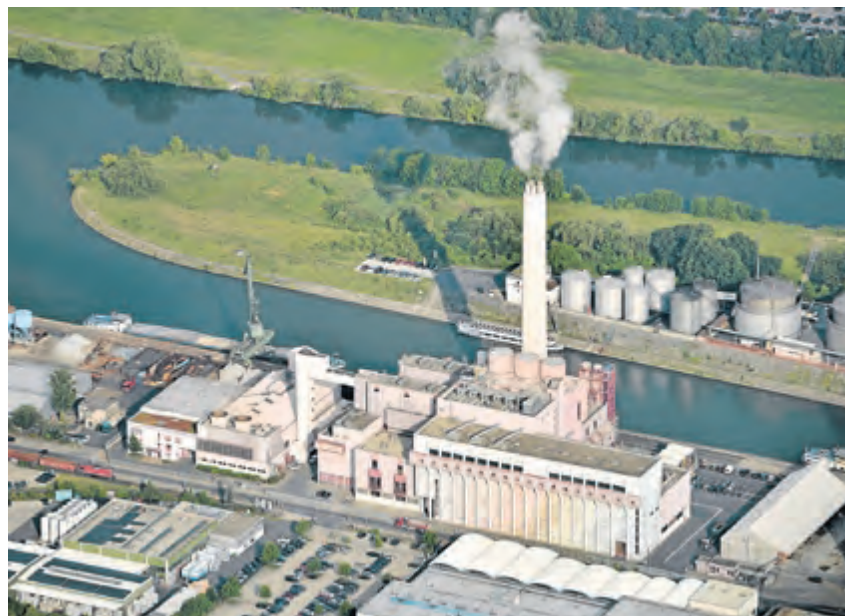
Blick auf das Gemeinschaftskraftwerk, dahinter das Hafenbecken und im Hintergrund der Main.
