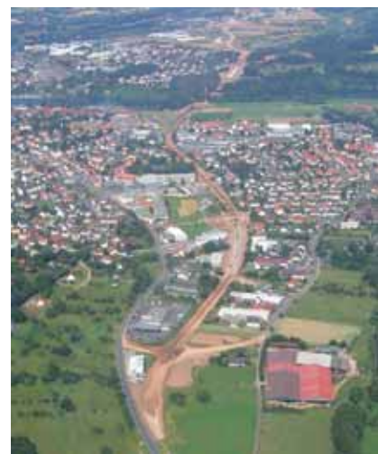
Luftbild von der Ausbaustrecke im Juli 2006.
