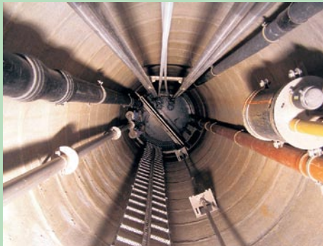
Blick in den 14,5 m tiefen Pumpschacht 1.
