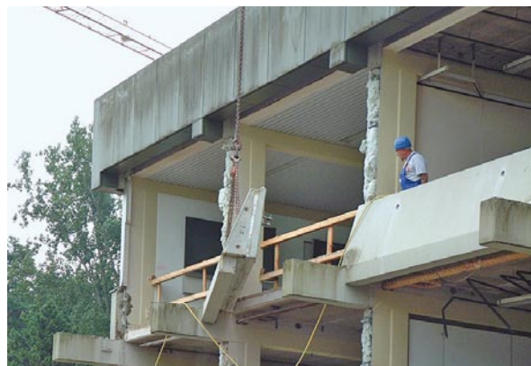
Rund 500 Tonnen Betonfertigteile müssen für die Generalsanierung des Julius-Echter-Gymnasiums zurückgebaut werden.
