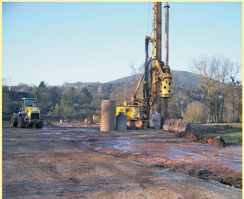
Die neue Mainbrücke Miltenberg-Bürgstadt: Niederbringen der Bohrpfähle mit schwerem Bohrergerät.
