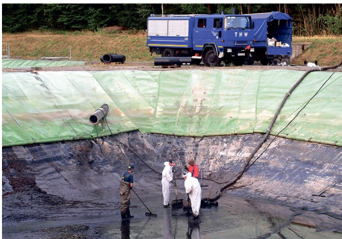
Arbeitseinsatz des THW OV Miltenberg
