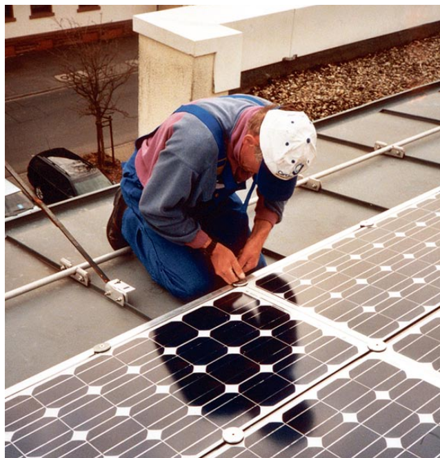
Installation der Solarmodule auf dem Dach des Landratsamtes Miltenberg.
