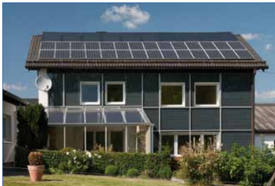
Effizienzhaus, Bild © dena
