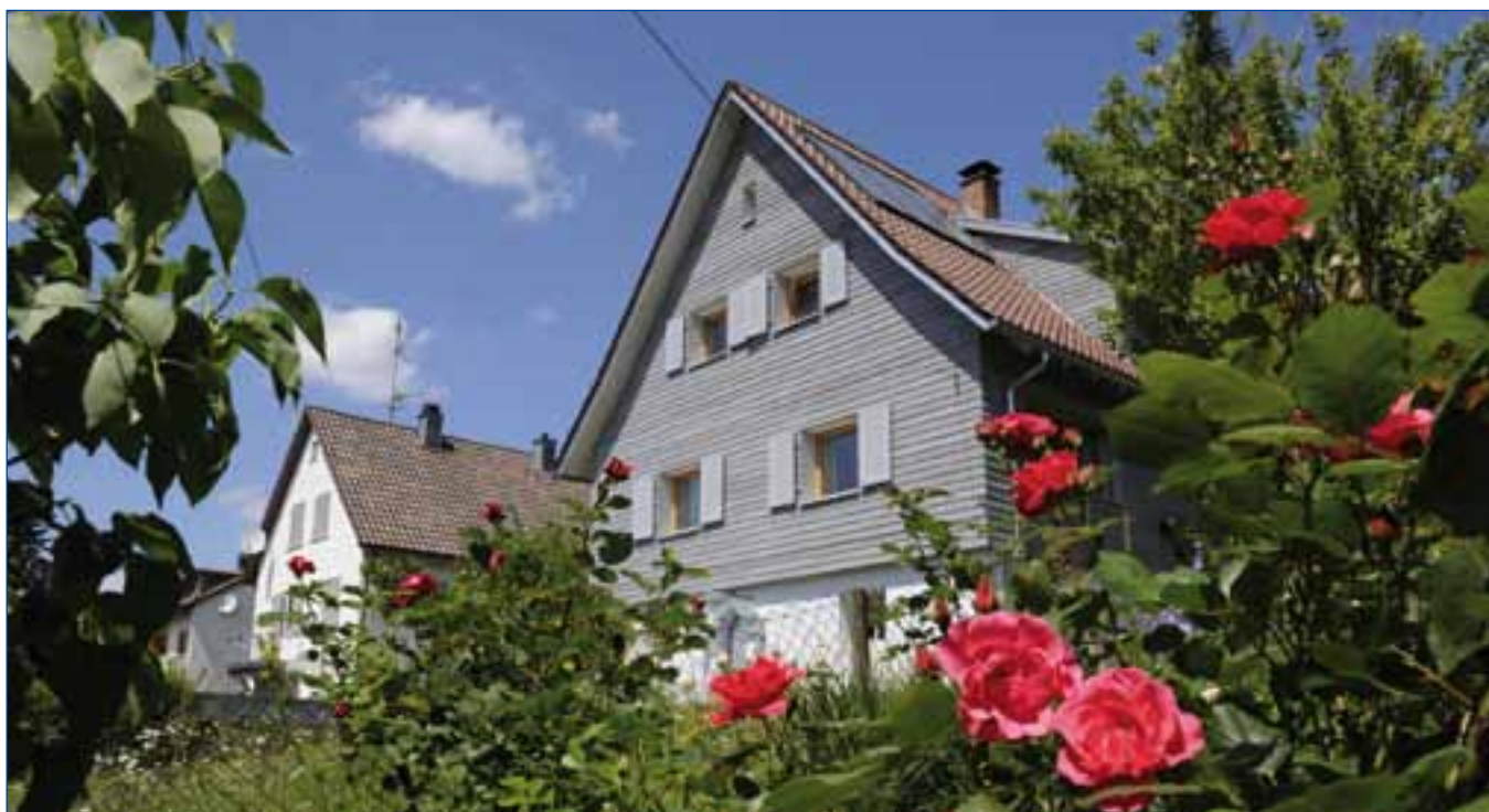
Effizienzhaus, Bild © dena
